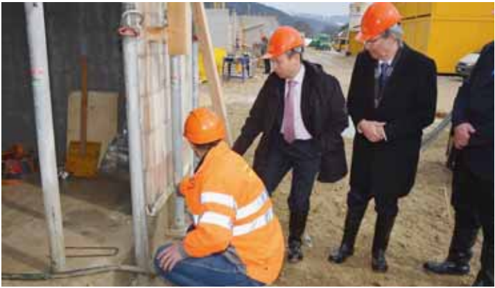
Officier technique de la Commission européenne, Mario Dionisio (debout, à gauche) a visité le chantier des Héliotropes. RICHARD LEUENBERGER
